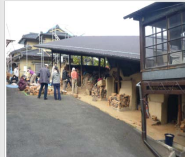
地震で倒壊した登り窯の修復
